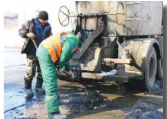
Для ремонта используется литой асфальтобетон. Эта технология допускает проведение работ и при отрицательных температурах, до минус 10 градусов.
