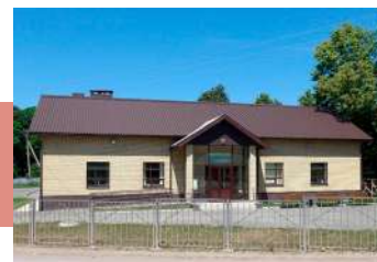
Здание Краснолесского ДК
